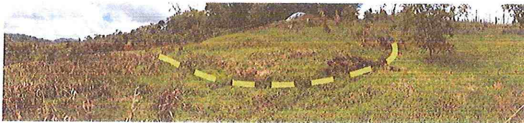
Fotografía 3 Grieta talud abajo - zona del depósito de acopio temporal
