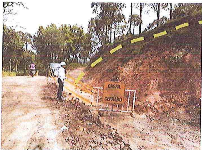
Fotografía 4 Falla del talud en PR0+600
