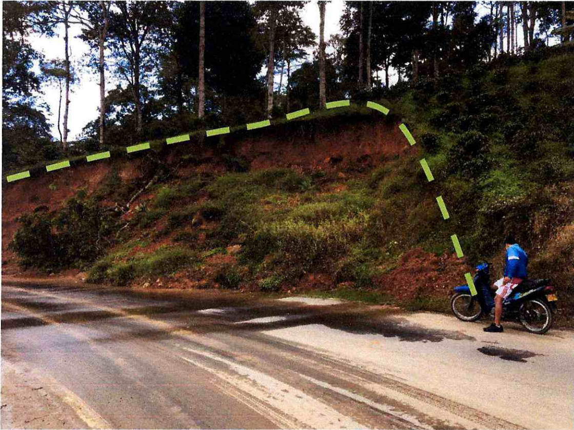
Fotografía 6 Falla del talud en PR0+600
