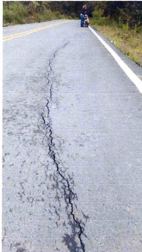
Fotografía 1 Grieta en la vía entre PR 1+005 y PR1+030
