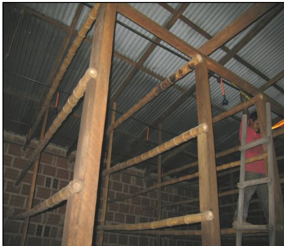
Figura 1. Instalación de los nebulizadores Foggers
