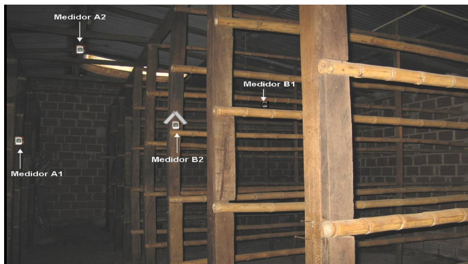
Figura 3. Vista de la fosa de tabaco y ubicación de los puntos de medición de las condiciones de temperatura y humedad relativa.
