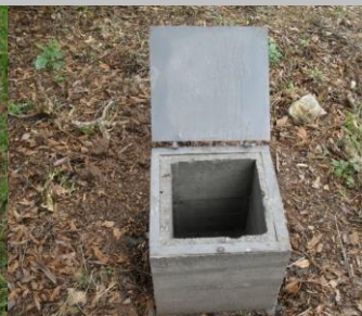
CONSTRUCCION CAJILLAS EN CONCRETO TOMA PREDIAL - TAPA LAMINA
