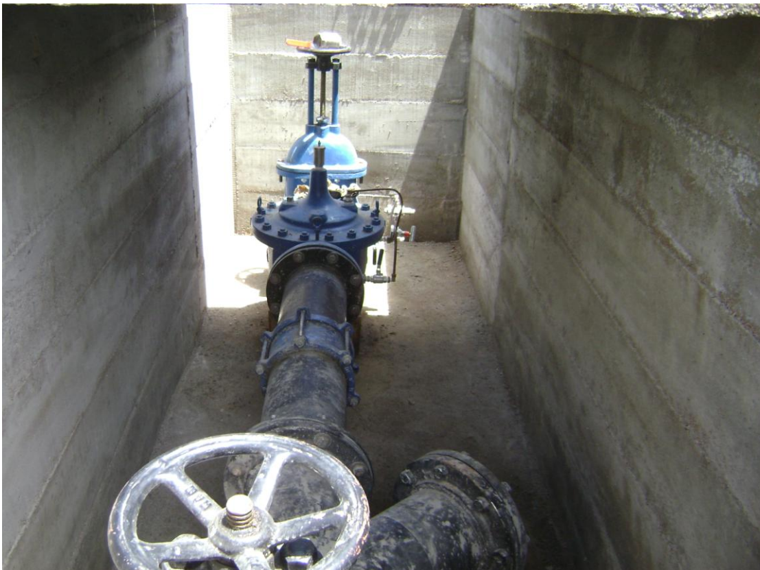
Estación reductora-reguladora. Distrito de riego Almorzadero- Teruel.
