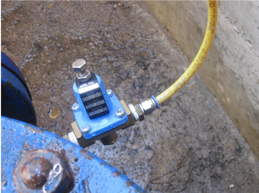
Válvula piloto de la válvula reguladora. Distrito de riego Almorzadero-Teruel.
