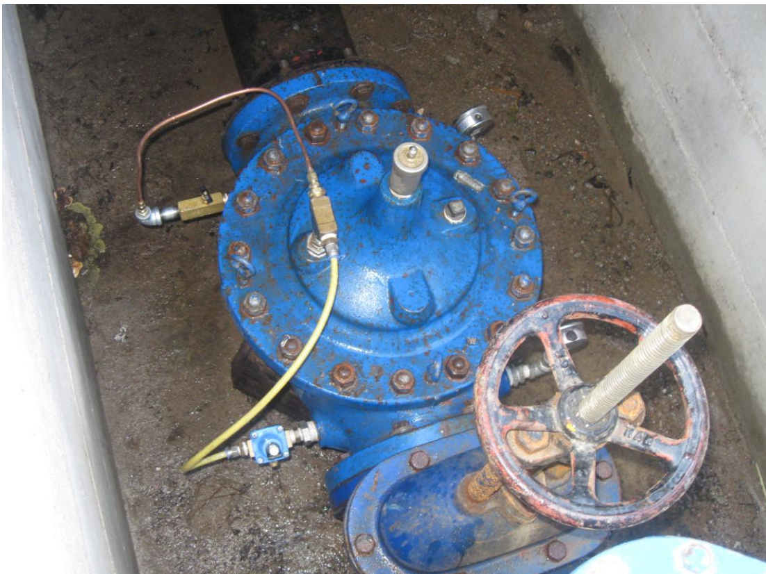
Válvula reguladora de presión. Distrito de riego Almorzadero-Teruel.
