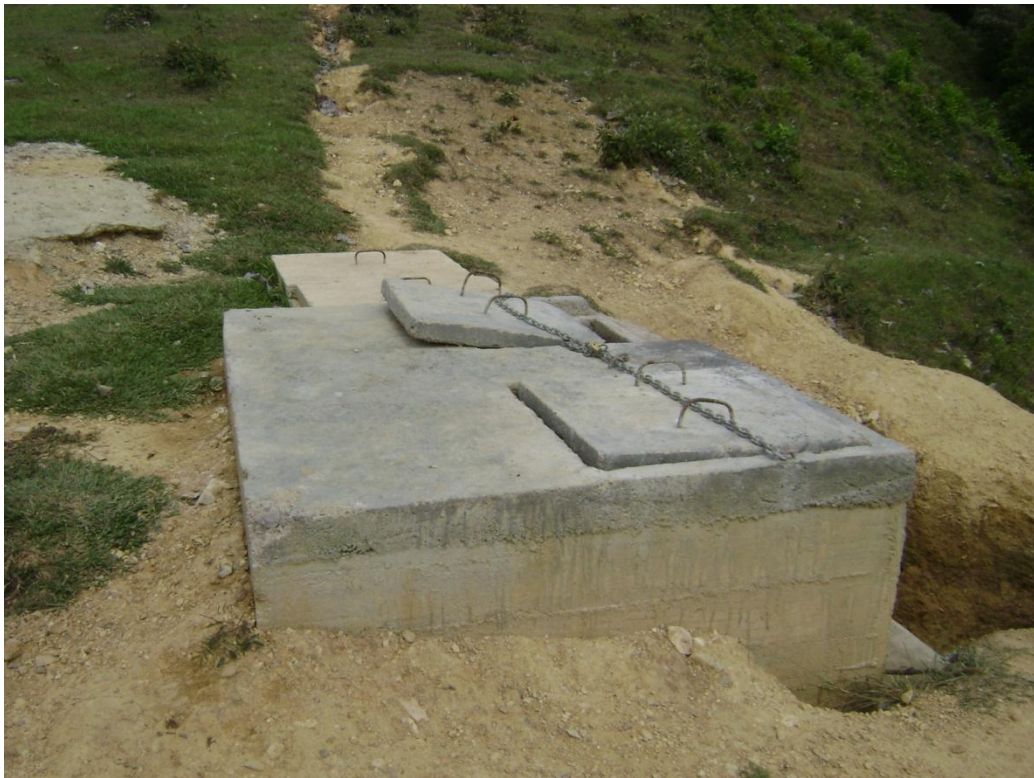
Cámara de quiebre de presión. Distrito de riego Almorzadero- Teruel
