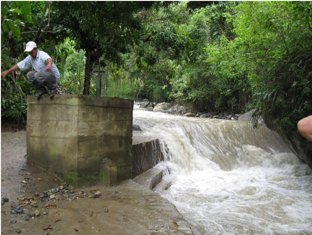
Bocatoma Distrito de riego Almorzadero-Teruel
