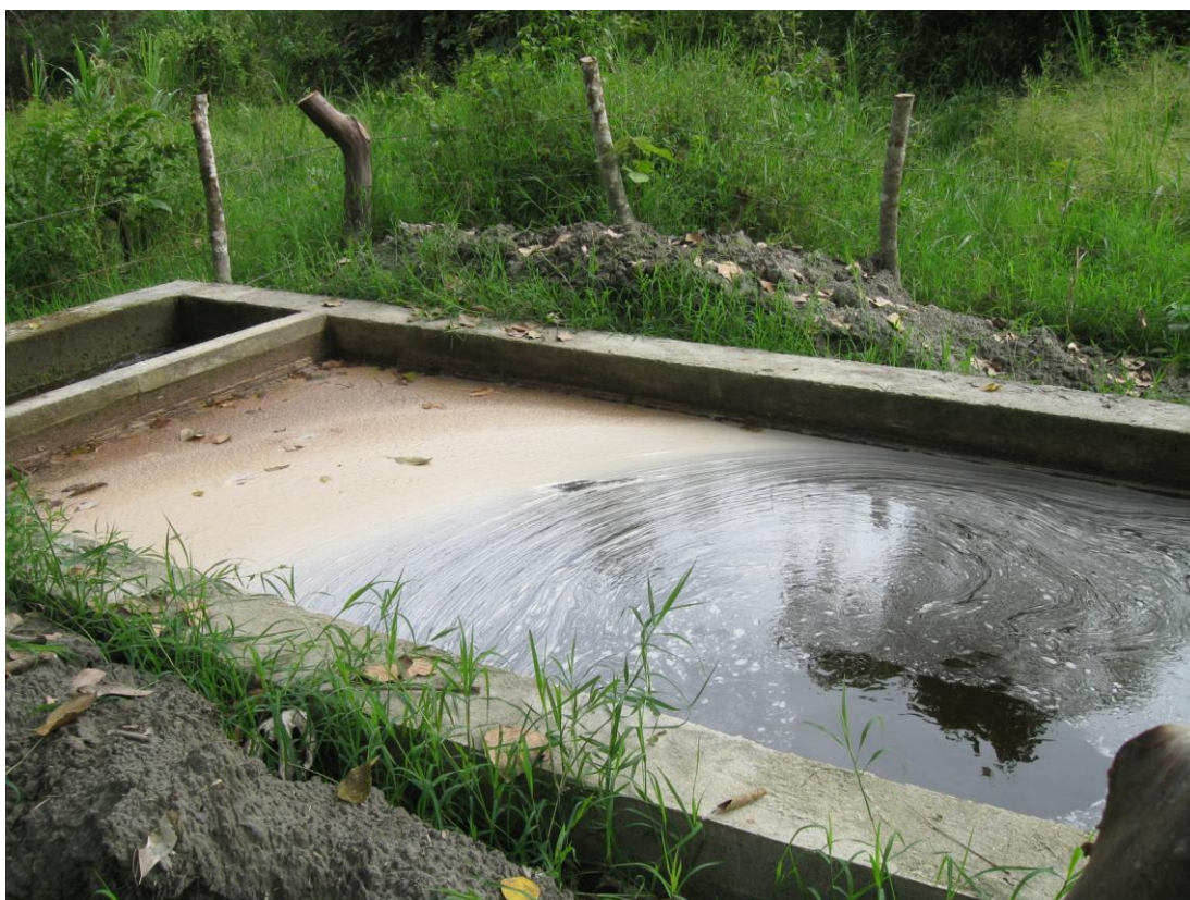
Desarenador. Distrito de riego Guandiosa. Gigante.
