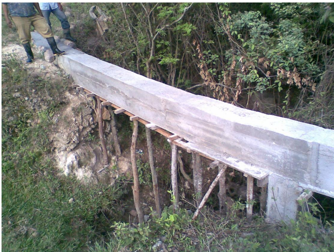
Encofrados. Distrito de riego Guandiosa-Gigante.
