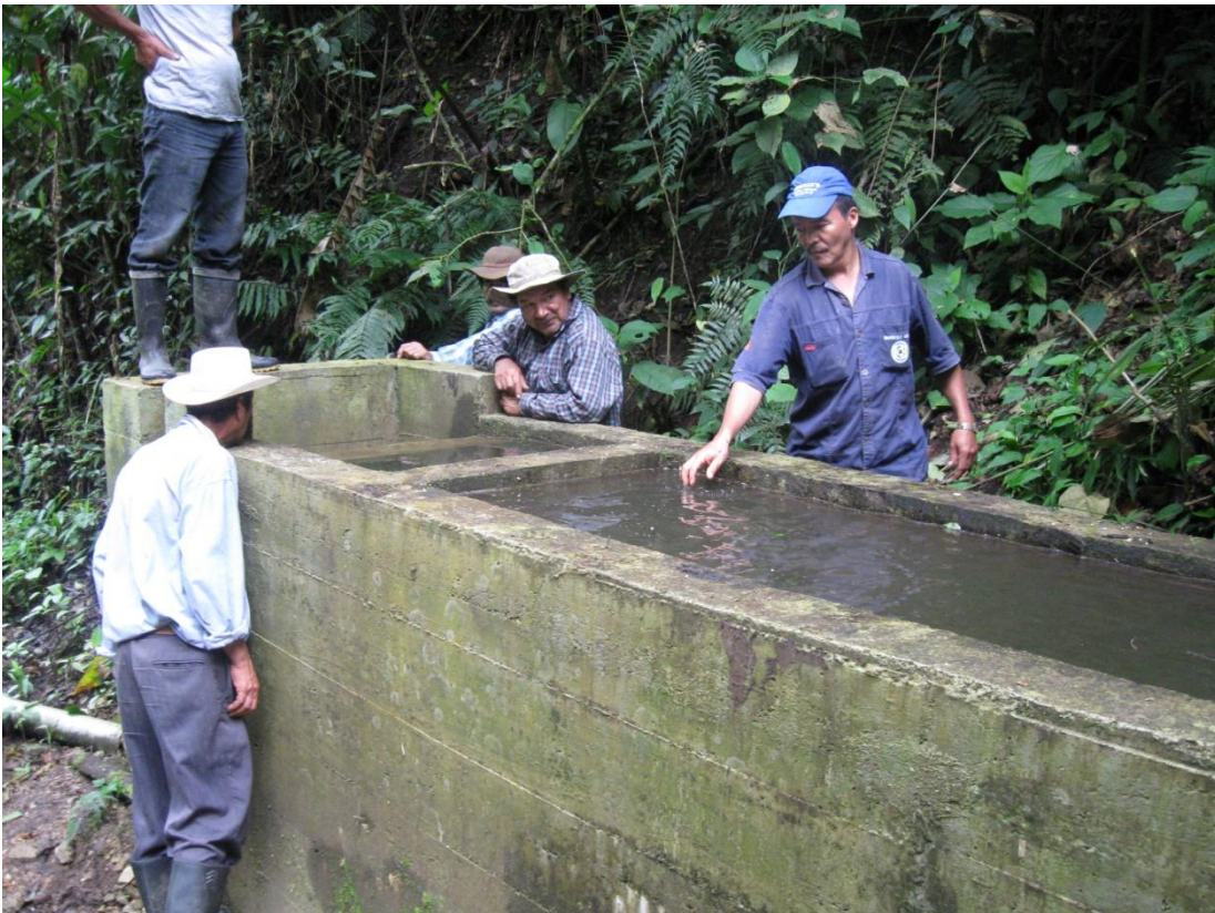
Desarenador. Distrito de riego Libano Oriente-Algeciras.
