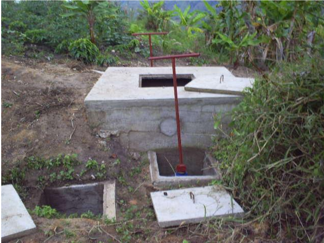
Cámara de quiebre de presión. Distrito de riego Libano Oriente-Algeciras
