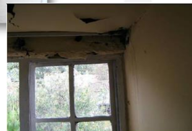
Eflorescencias y podredumbre de pintura en muro oriental
