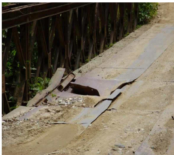
Foto: Estructura donde han quedado muchas volquetas atoradas en estas falsas láminas, que ya no soportan el peso.
