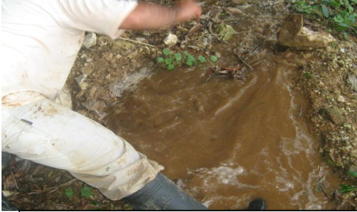
DAÑO PRESENTADO DURANTE LAS PRUEBAS HIDRÁULICAS TUBERÍA DE 8" LINEA DE
