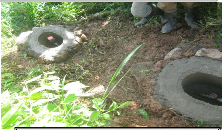
CONSTRUCCIÓN E INSTALACIÓN DE CAJILLAS PREDIALES INCLUYE HIDRANTE
