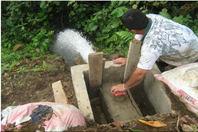
LAVADO Y PURGA A LA TUBERÍA DE CONDUCCIÓN DE 10"
