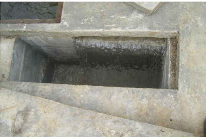
LLENADO Y PRUEBA DE ESTANQUEIDAD TANQUE
