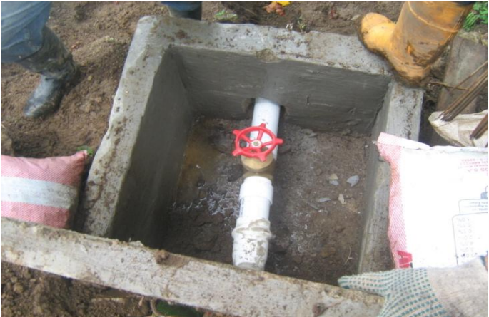
CAJILLA DE CONTROL VÁLVULA DE LAVADO TUBERÍA
