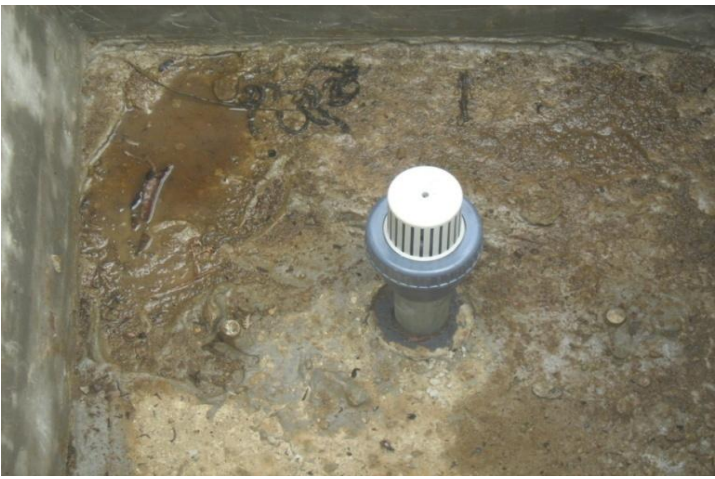
INSTALACIÓN VÁLVULA VENTOSA SOBRE LÍNEA DE
