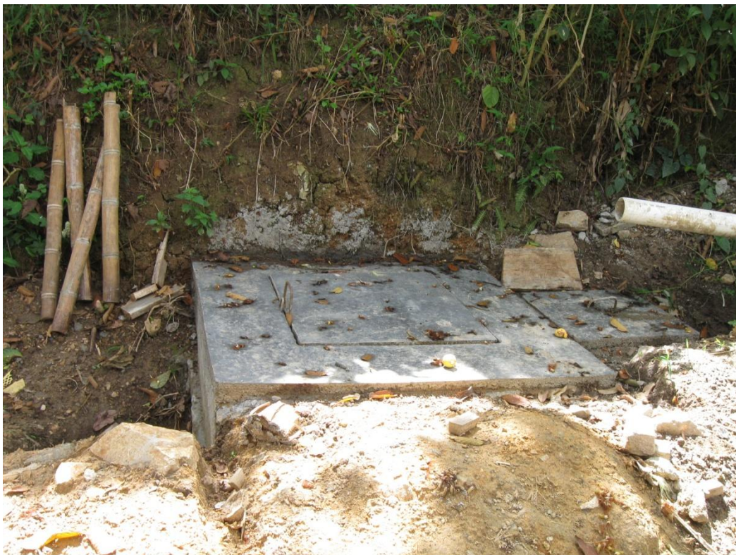
Cámara de quiebre de presión. Distrito de riego La Unión, Las Ceibas- Garzón
