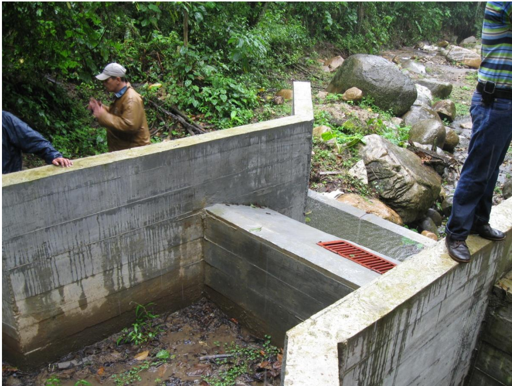
Bocatoma. Distrito de riego La Unión, las Ceibas- Garzón
