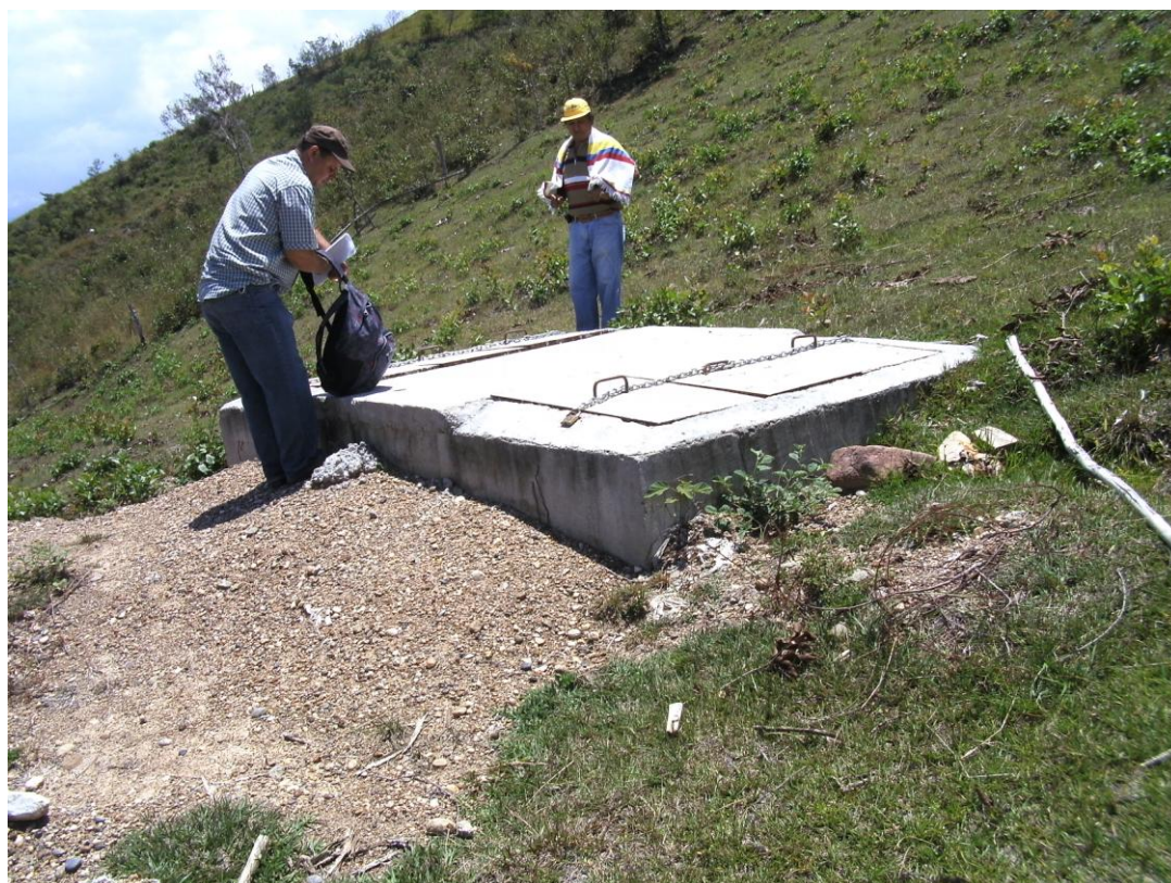
Camara-Estacion reductora-reguladora. Distrito de riego Lagunilla- Tarqui.
